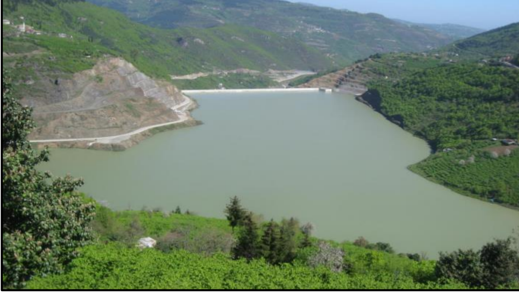
Şekil 1.8: Trabzon İli Atası Barajı ve HES İnşaatının Genel Görünümü. (DSİ 22. Bölge Müdürlüğü, 2021)
