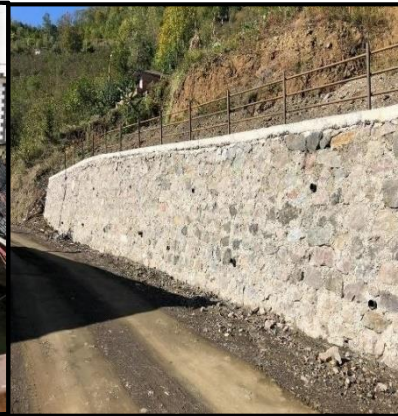
Şekil 1.25: Trabzon İli, Çaykara, Akçaabat ve Maçka İlçelerinde Heyelan Önleyici İstinat Duvarları. (AFAD Trabzon, 2021)
