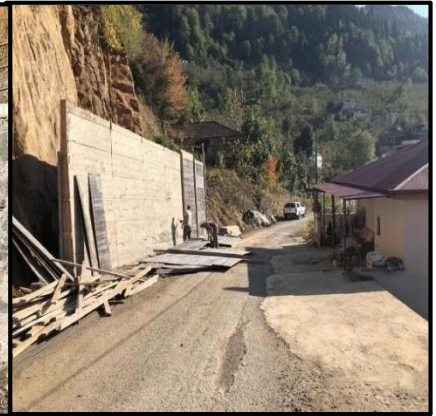
Şekil 1.25: Trabzon İli, Çaykara, Akçaabat ve Maçka İlçelerinde Heyelan Önleyici İstinat Duvarları. (AFAD Trabzon, 2021)
